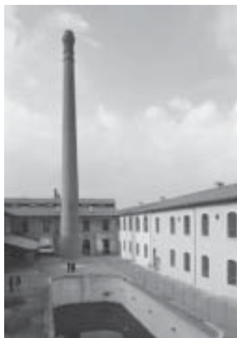
Esterno del museo: veduta del cortile interno della ex fabbrica
